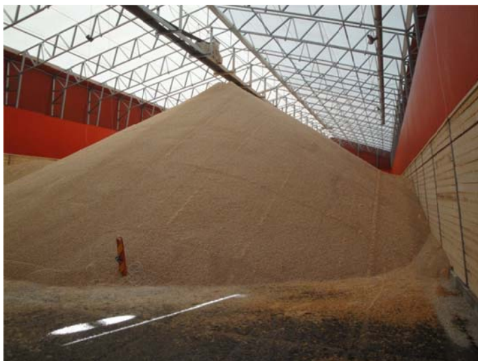
Bild 2 PVC-hall med träpellets.
